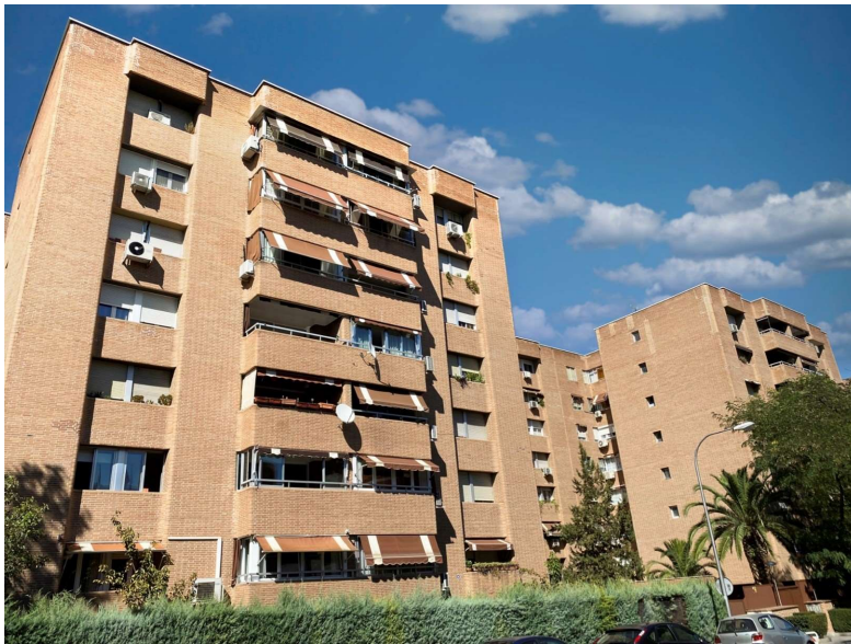
Fig. 17: Bloque de viviendas
